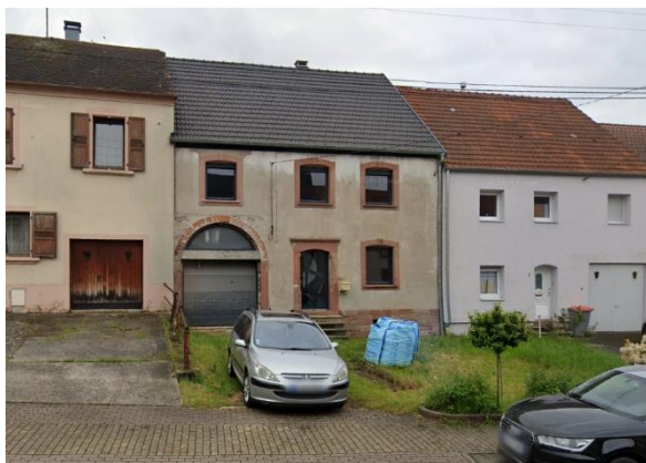
Porte de grange convertie en porte de garage avec encadrement préservé (à gauche) – Porte de grange murée pour la création d'une porte de garage (à droite), source AdT
