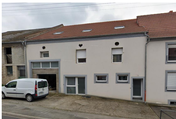
Porte de grange convertie en porte de garage avec encadrement préservé (à gauche) – Porte de grange murée pour la création d'une porte de garage (à droite), source AdT
