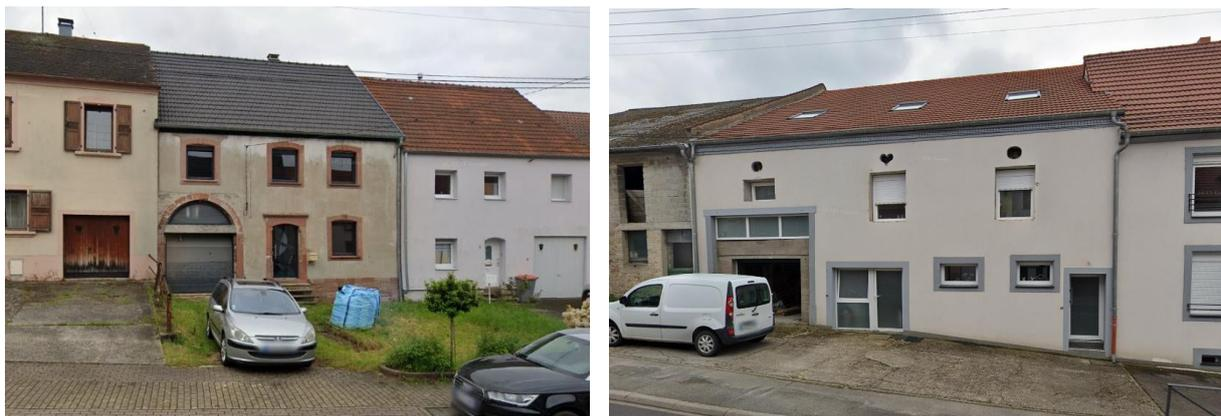
Porte de grange convertie en porte de garage avec encadrement préservé (à gauche) – Porte de grange murée pour la création d'une porte de garage (à droite), source AdT
